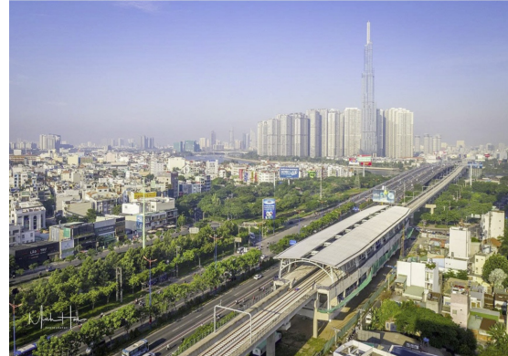
Tuyến đường sắt Bến Thành - Suối Tiên đã đi vào hoạt động sau gần 20 năm xây dựng.
