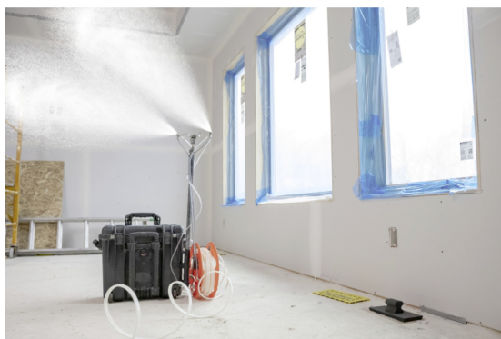
Công nghệ phun sương Aerobarrier tự động bịt kín các khe hở, rò rỉ khí trong nhà ở và công trình.
