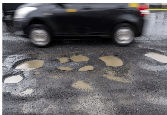
Qua thời gian, bê tông nhựa truyền thống suy giảm khả năng chịu lực dưới tác động của xe cộ và thời tiết, tạo ra các vết nứt và ổ gà.
