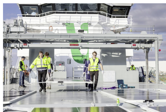
44 tấm Solar Flatrack được lắp đặt để cung cấp điện cho các hệ thống trên tàu. Nguồn Wattlab
