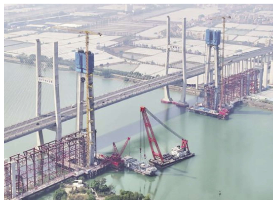
Việc xây dựng hệ thống đường sắt hiện đại tại Vùng Vịnh Lớn đang được đẩy mạnh.
