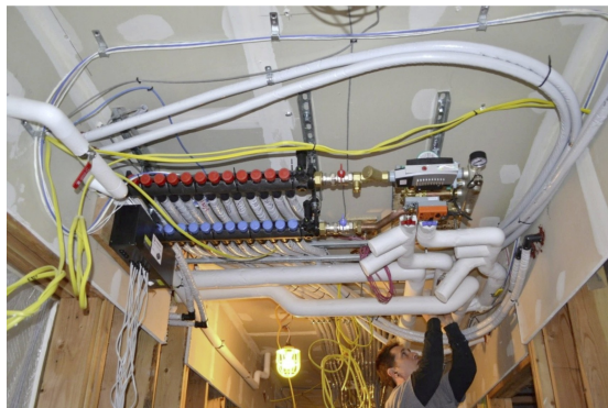
Lắp đặt hệ thống Ray Magic, sử dụng các tấm thạch cao bức xạ để làm mát và sưởi ấm phòng.
