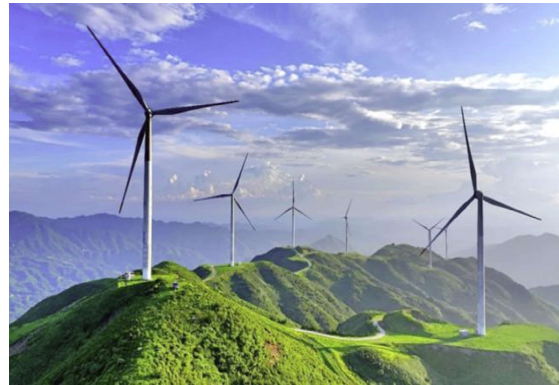
Hệ thống tua-bin gió của Dự án điện gió Chính An.
