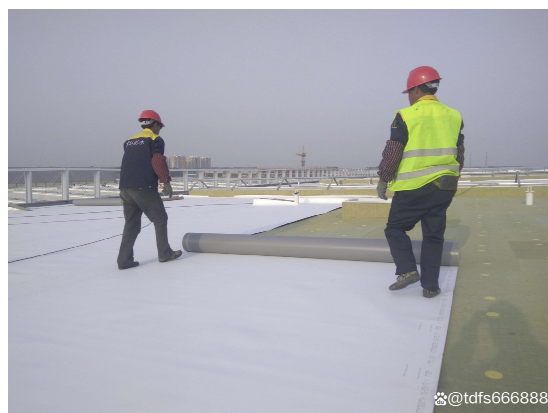
Kỹ sư xây dựng đang thi công phủ màng chống thấm hai lớp TPO.
