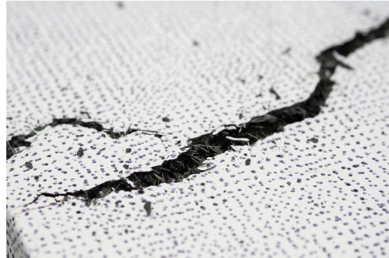
Vết nứt hình thành trong quá trình thí nghiệm làm lộ ra các sợi thép gia cường trong bê tông siêu bền.
