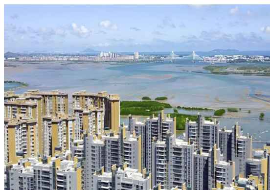
Các mục tiêu của ngành Xây dựng Trung Quốc trong Kế hoạch 5 năm lần thứ 15 dần được định hình rõ nét.
