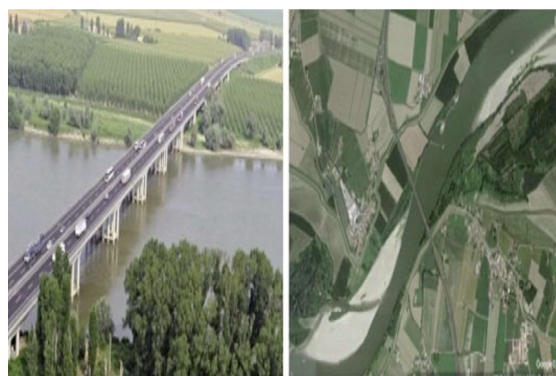
Sử dụng MT-Insar giám sát cầu trên đường A22 bắc qua sông Po, Ý.
