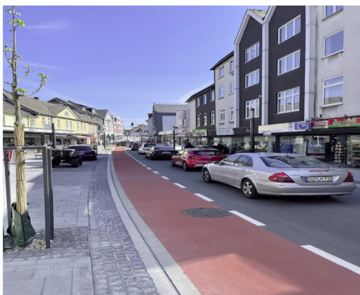
Làn đường dành cho xe đạp được sơn màu rõ ràng với lớp phủ EP-GRIP VELO của Possehl Spezialbau tại trung tâm thành phố Waldbröl, giúp tăng khả năng quan sát, an toàn và sự thoải mái khi di chuyển trong giao thông đô thị.
