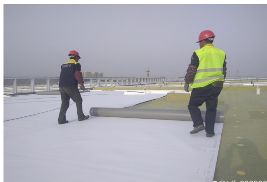
Kỹ sư xây dựng đang thi công phủ màng chống thấm hai lớp TPO.
