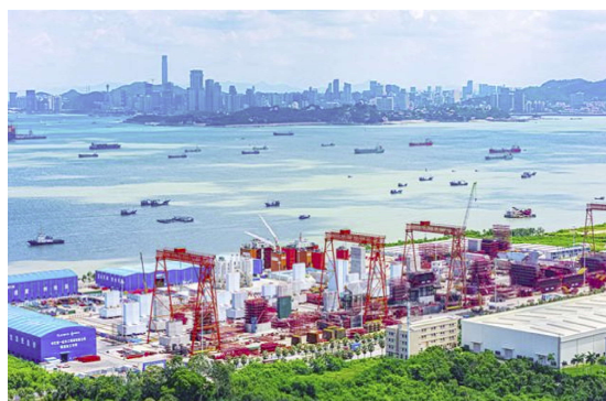
Công trường đúc sẵn trụ cầu Dự án Cầu Hạ Môn - Kim Môn.
