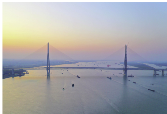
Cầu Trường Thái Trường Giang.
