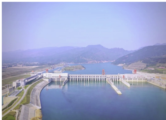
Công trình chính của cụm thủy lợi Đại Đằng Hiệp.
