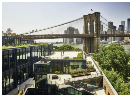
Vườn trên mái.
