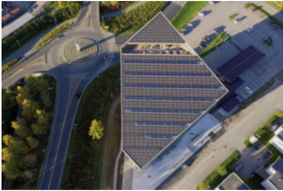
Mái tòa nhà Powerhouse Telemark (Na Uy) bao phủ toàn bộ bằng các panel pin mặt trời.
