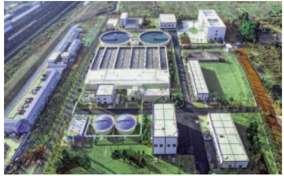
Toàn cảnh Nhà máy xử lý nước thải Kim Sơn (thành phố Chu Châu).
