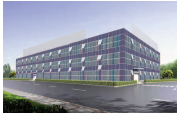
Hệ thống tường bao tích hợp hệ thống quang điện.
