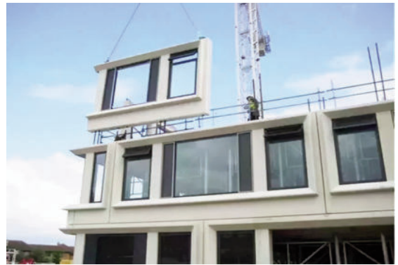
Xây dựng tiên chế lắp ráp.
