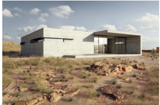
Sharp House được thiết kế để tiết kiệm chi phí nhất có thể trong xây dựng, với bê tông đúc tại chỗ lộ thiên và kính lớn ở phía bắc và phía nam để thu năng lượng mặt trời và thông gió chéo.
