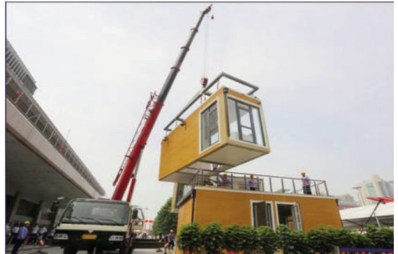
Mô hình công trình tiên chế hiện thực hóa mục tiêu xây nhà như lắp ráp ô tô
