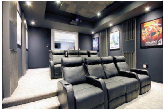
Tấm tiêu âm gắn trên tường và trần giúp hấp thụ năng lượng âm thanh.
