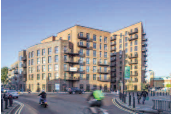
Dalston Works là một trong những tòa nhà gỗ khối cao nhất thế giới được xây dựng trên khu đất bị ô nhiễm trước đây.
