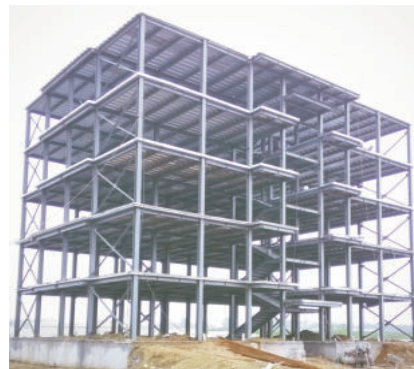
Nhà xây khung thép
