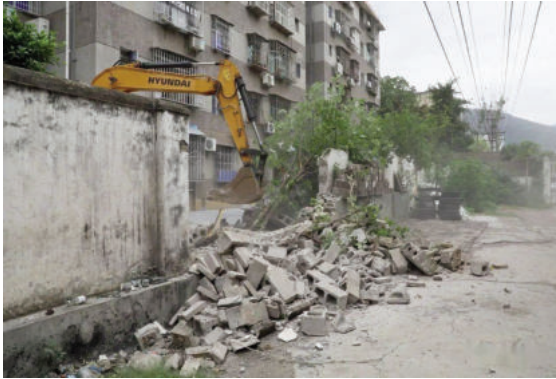
Tăng cường phá dỡ, cải tạo nhà ở xuống cấp tại huyện Nguyên Giang (Vân Nam, Trung Quốc)
