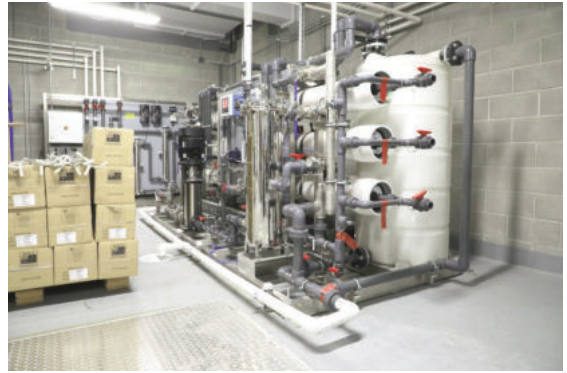
Một phần của hệ thống lọc nước tại Tháp Salesforce bao gồm máng trượt thấm thấu ngược. / Thời báo New York
