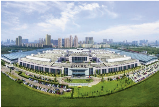
Tập đoàn LianBao Electronic Technology (thành phố Hợp Phi)
