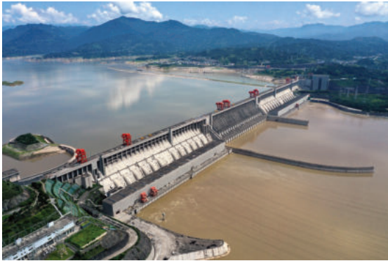
Nhà máy điện Tam Hiệp (thành phố Tân Bắc)
