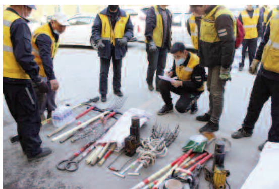
Rà soát lại dụng cụ máy móc trước khi đưa vào công trường.
