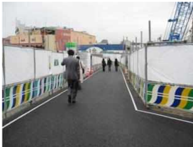
Hình 28. Sử dụng loại hàng rào sáng màu, sơn viền sáng màu ngăn cách chân hàng rào và lối đi bộ để tăng khả năng nhận diện hàng rào
