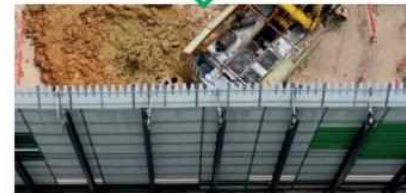
Hình 36. Hàng rào chống ồn với đầu nghiêng răng cưa sẽ hoạt động tốt hơn
