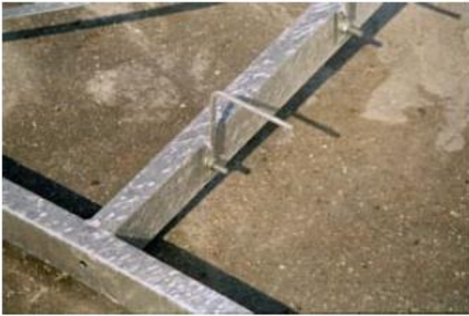
Hình 1.18 – Neo flex điển hình [3]
