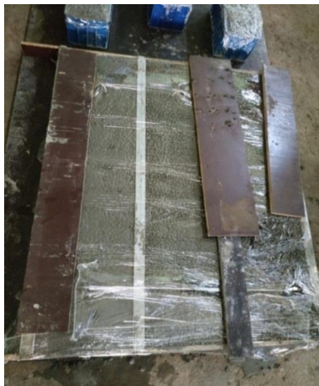
Hình 5 Bảo dưỡng tấm tường bê tông bằng màng PVC
