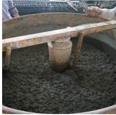
Hình 2 Công tác trộn hỗn hợp bê tông nhẹ
