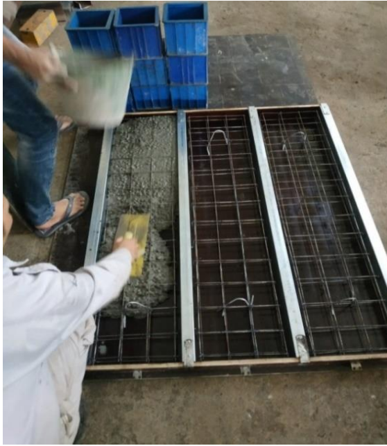
Hình 3 Công tác đổ bê tông tấm tường
