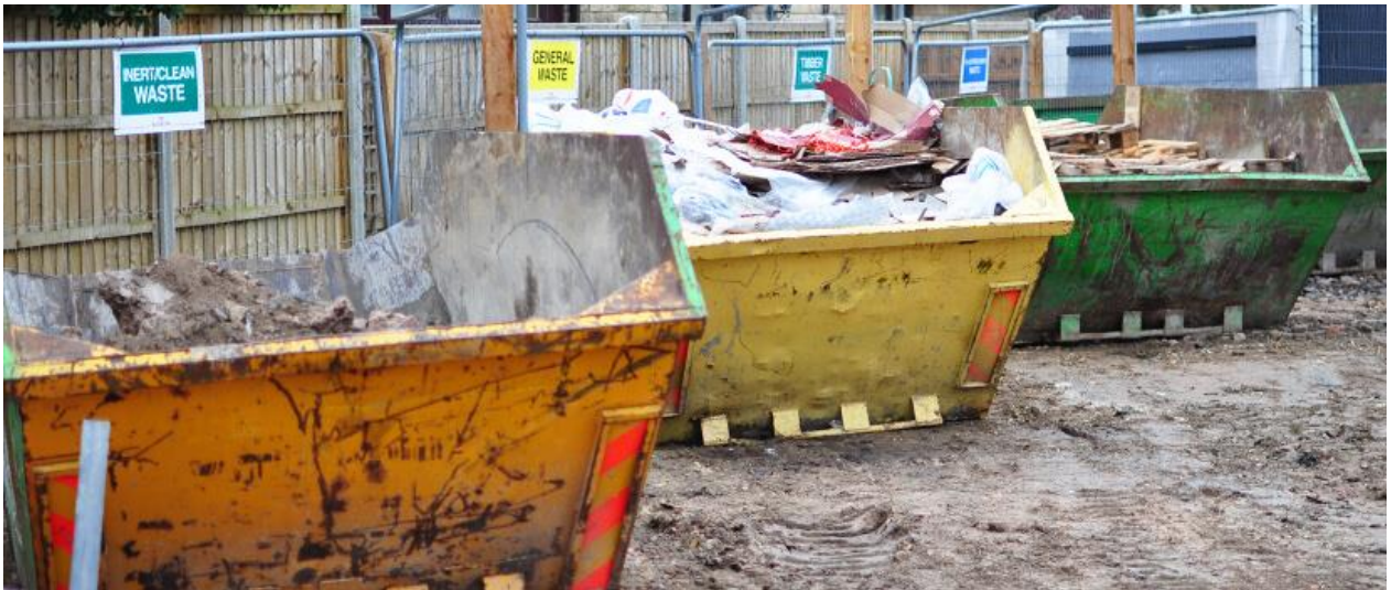
Hình 4. Ví dụ thùng chứa CTRXD thông thường tại công trường phá dỡ
