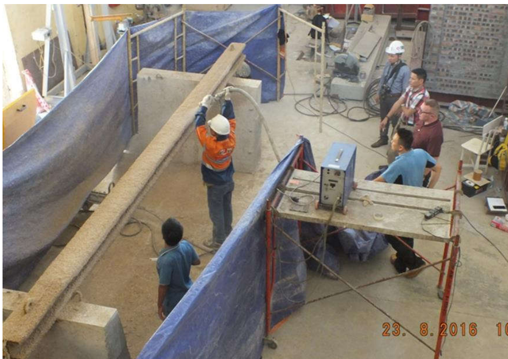
Hình 37 – Ví dụ thi công phun vữa bọc bảo vệ chịu lửa cho dầm thép
