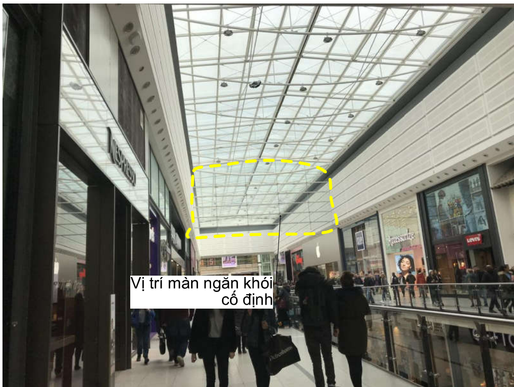
Hình 18 – Ví dụ về bố trí màn ngăn khói cố định để ngăn chia vùng khói trên mái sảnh thông tầng
