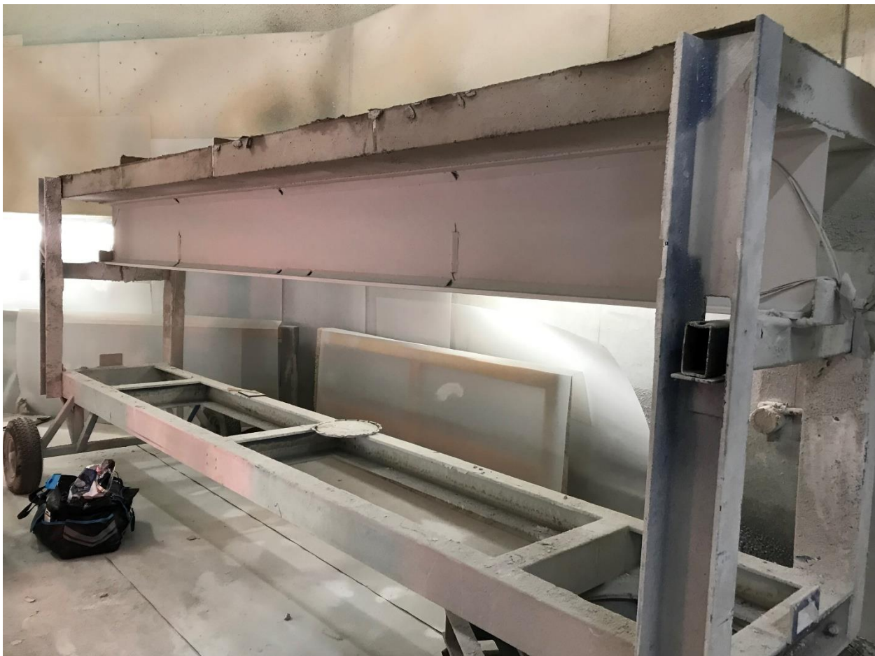
Hình 26 – Ví dụ sơn bọc bảo vệ cấu kiện dầm thép bằng sơn trương phồng
