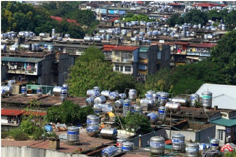
Hình 1. Hình ảnh các bồn nước được lắp đặt trên nóc của các khu tập thể cũ
