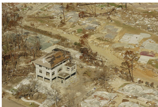
Được xây dựng bằng vật liệu ICF, ngôi nhà này đã chống chịu được với cơn bão Katrina và là một trong số rất ít ngôi nhà còn sót lại sau khi cơn bão Katrina đổ bộ vào Mississippi (Mỹ).
