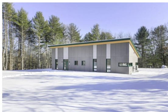
Các bức tường bên ngoài chủ yếu được làm bằng xi măng sợi màu của Cement Board Manufacturers.
