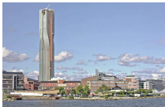
Tòa nhà cao tầng Karlatornet ở Gothenburg khi đang trong quá trình xây dựng. Công trình hiện đã hoàn thành và trở thành tòa nhà cao nhất tại Scandinavia.
