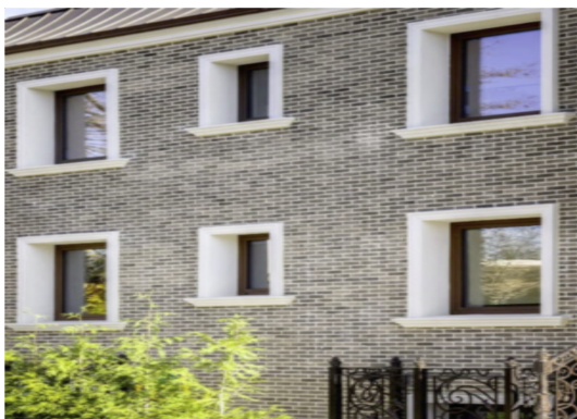
Các ô cửa sổ sâu của dự án Middle Village cho thấy độ dày của các khối bê tông cách nhiệt giúp tạo ra môi trường kín khí, được sưởi ấm thụ động. Ảnh do NODE Architecture, Engineering and Consulting cung cấp.
