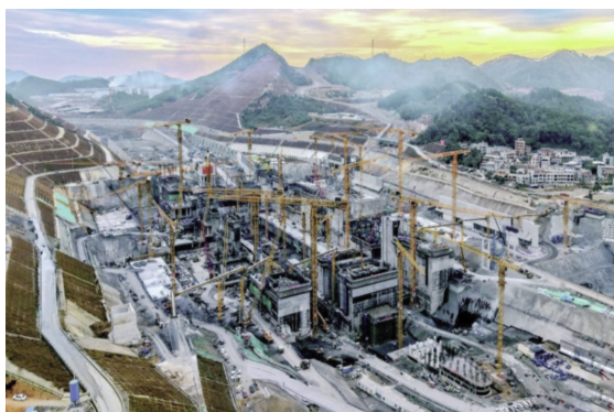
Dàn cầu tháp XCMG thi công tại một đại công trường ở Trung Quốc.
