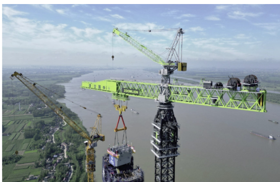
Zoomlion ra mắt cầu tháp 20.000 tấn-mét đầu tiên trên thế giới tại dự án đường sắt liên đô thị Chaohu-Maanshan.
