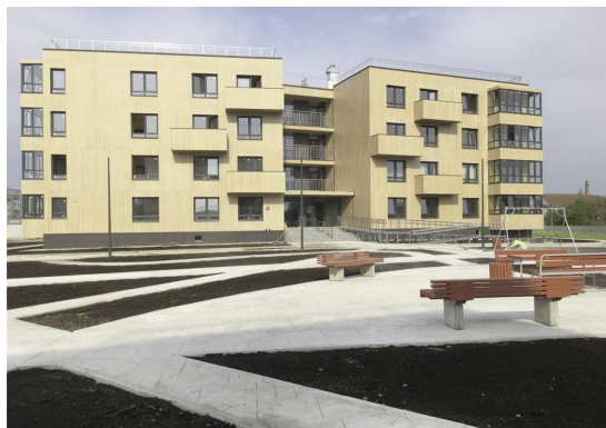
Chung cư 4 tầng bằng gỗ tại thành phố Sokol (Nga).
