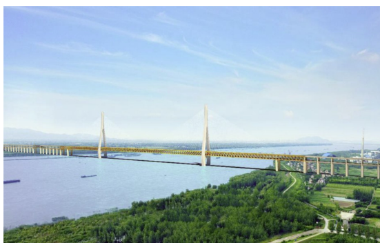
Tuyến đường sắt cao tốc Hợp Trì - cầu đường sắt và đường bộ Trì Châu vượt sông Trường Giang đang trong giai đoạn thi công.
