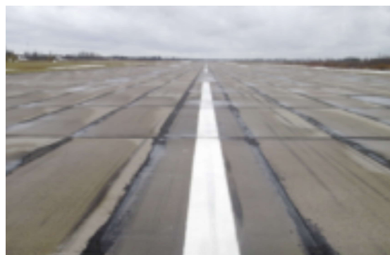
Thời hạn sử dụng được bảo hành của chất trám bitum-polymer đổ vào các khe co giãn, ở trạng thái không có khuyết tật, theo nghiên cứu này là hai năm.
