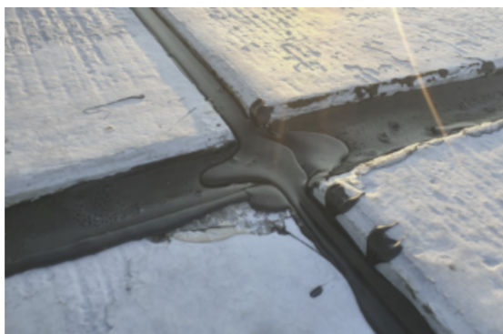
Chất trám bitum-polymer là vật liệu phổ biến nhất trong việc trám các khe co giãn khi xây dựng và sửa chữa mặt đường sân bay.
