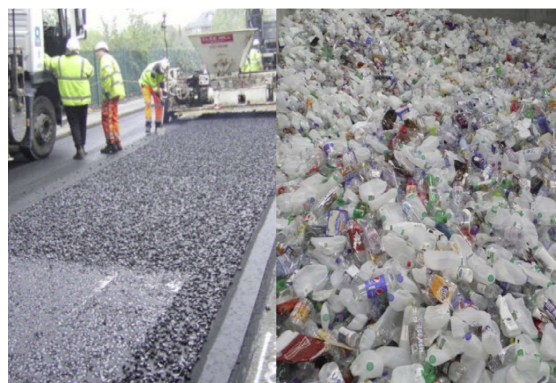
Rác thải nhựa làm vật liệu đắp nền đường.
