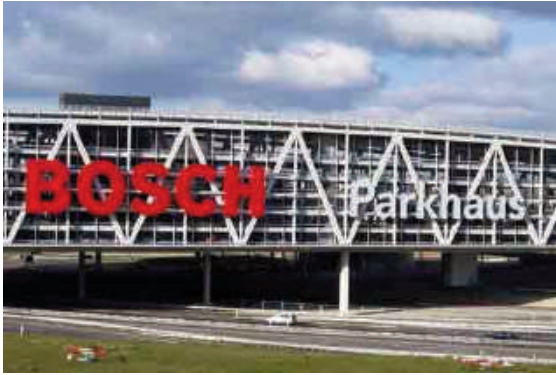
Nhà - cầu Bosch Parkhaus, Stuttgart, Đức
