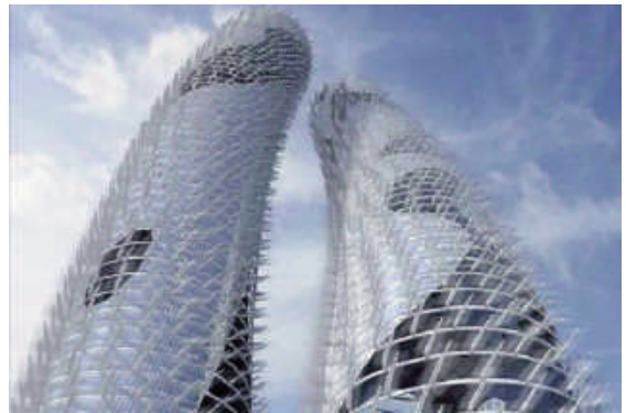
Gullwing Twin Wind Tower Dubai với cấu trúc mặt dựng là các turbin gió
