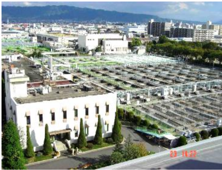
Ảnh 1: Toàn cảnh trạm xử lý Hirano có công suất 270.000m 3 /ngày đêm.
