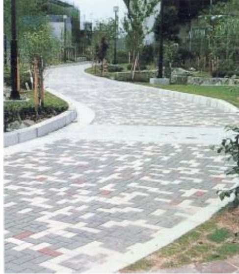
Ảnh 8: Gạch lát đường đi bộ, có độ thấm cao được làm từ bùn thải, xây dựng tại T.P Osaka.
