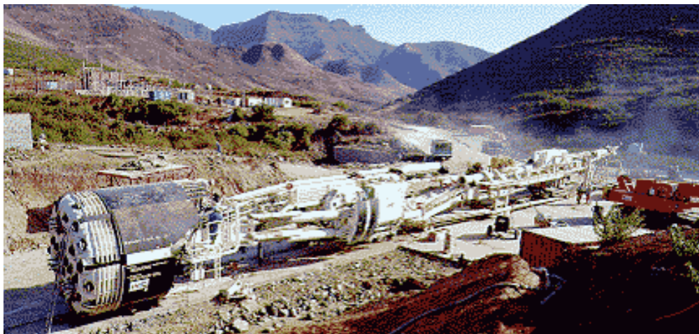
Hình 8: Lắp ráp TBM của hãng Robbins
