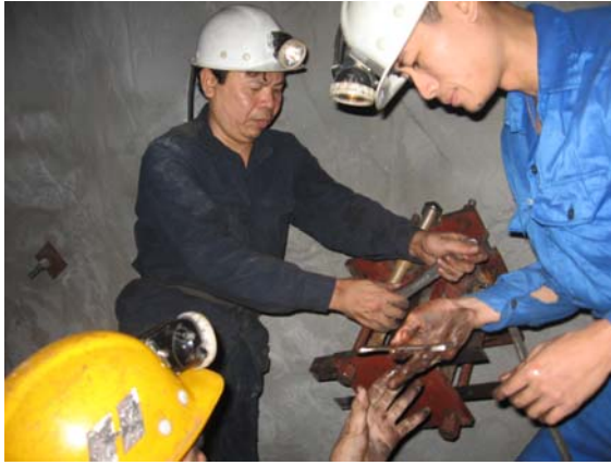
Hình 15. Lắp đặt dụng cụ thử tải
