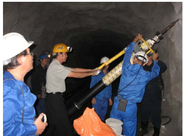
Hình 14. Lắp đặt neo chất dẻo
