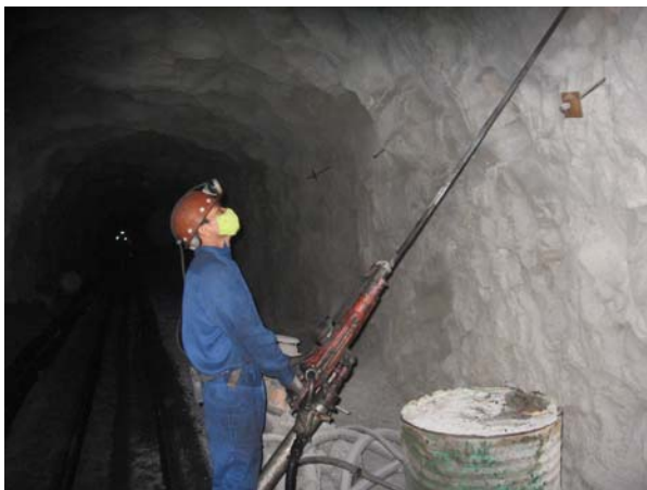
Hình 13. Khoan tạo lỗ neo
