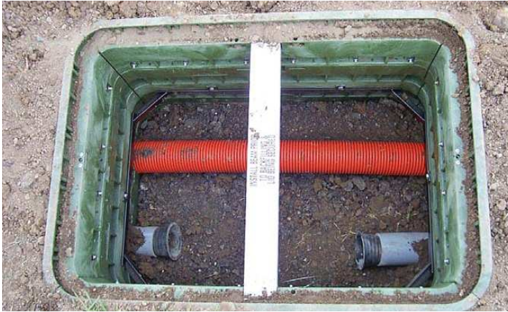
Hình 3: Lắp đặt hoàn chỉnh Handhole (nắp đã được mở) - Thử nghiệm Pha I
